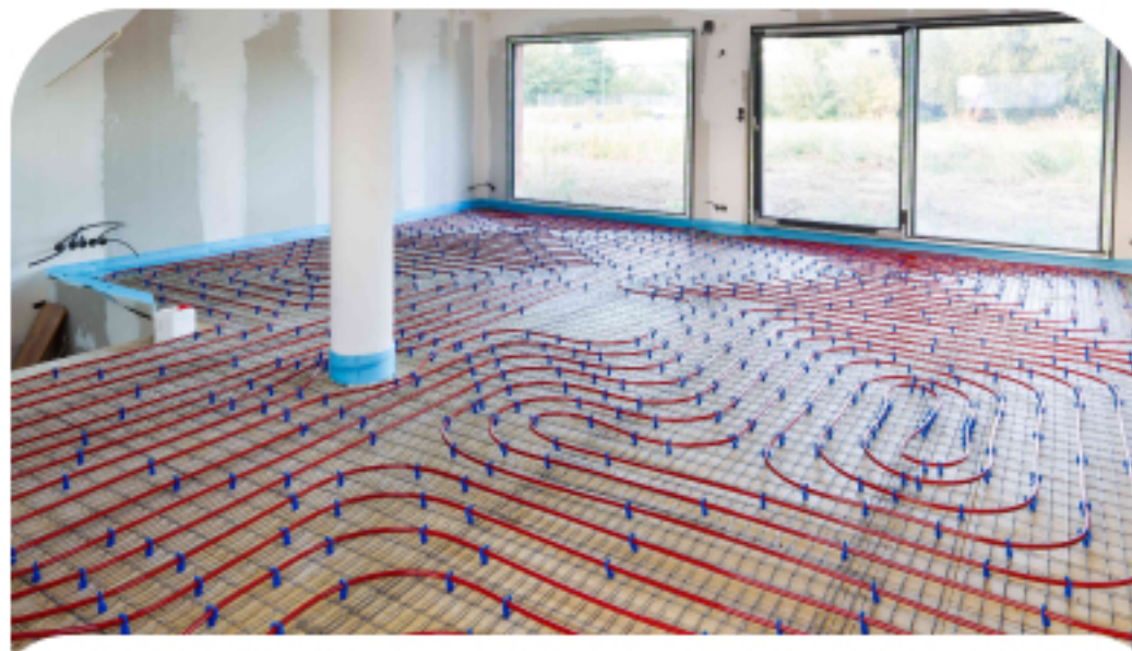
Монтаж теплых полов
