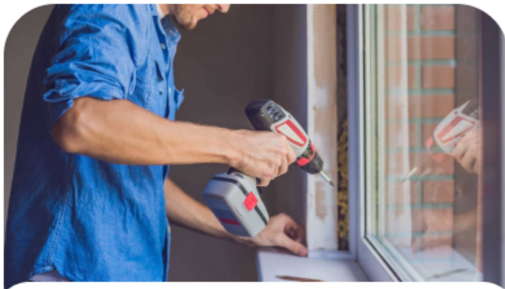
Монтаж окон, дверей
