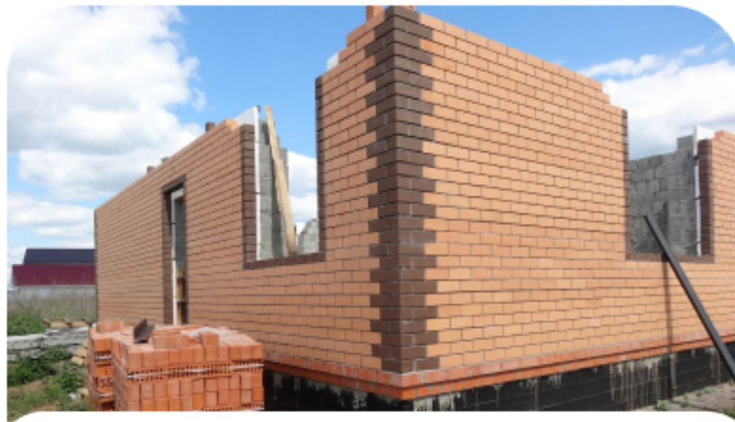
Устройство несущих стен и перегородок, утепление, облицовка фасада
