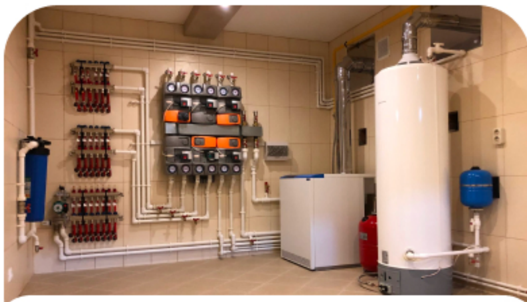
Монтаж внутренней инженерной системы
