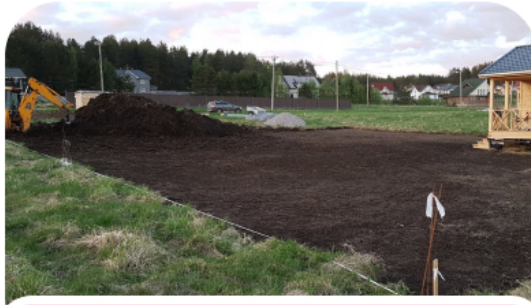
Снятие плодородного слоя и устройство инженерных сетей (скважина и септик)
