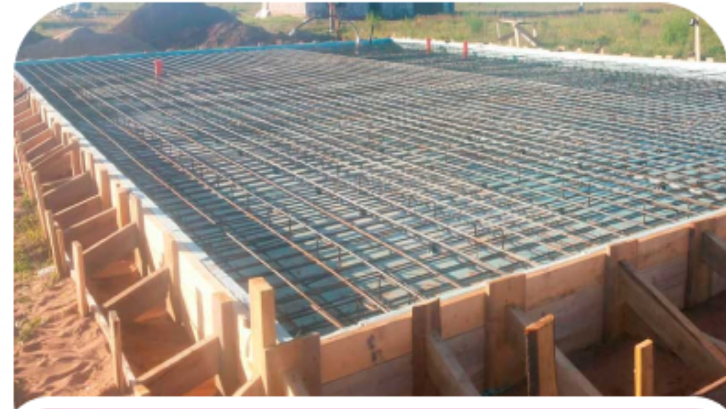
Опалубка, устройство коммуникаций, отсыпка песком – щебнем, монтаж арматурного каркаса
